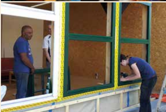
Einbau der alten TÜWI-Fenster
