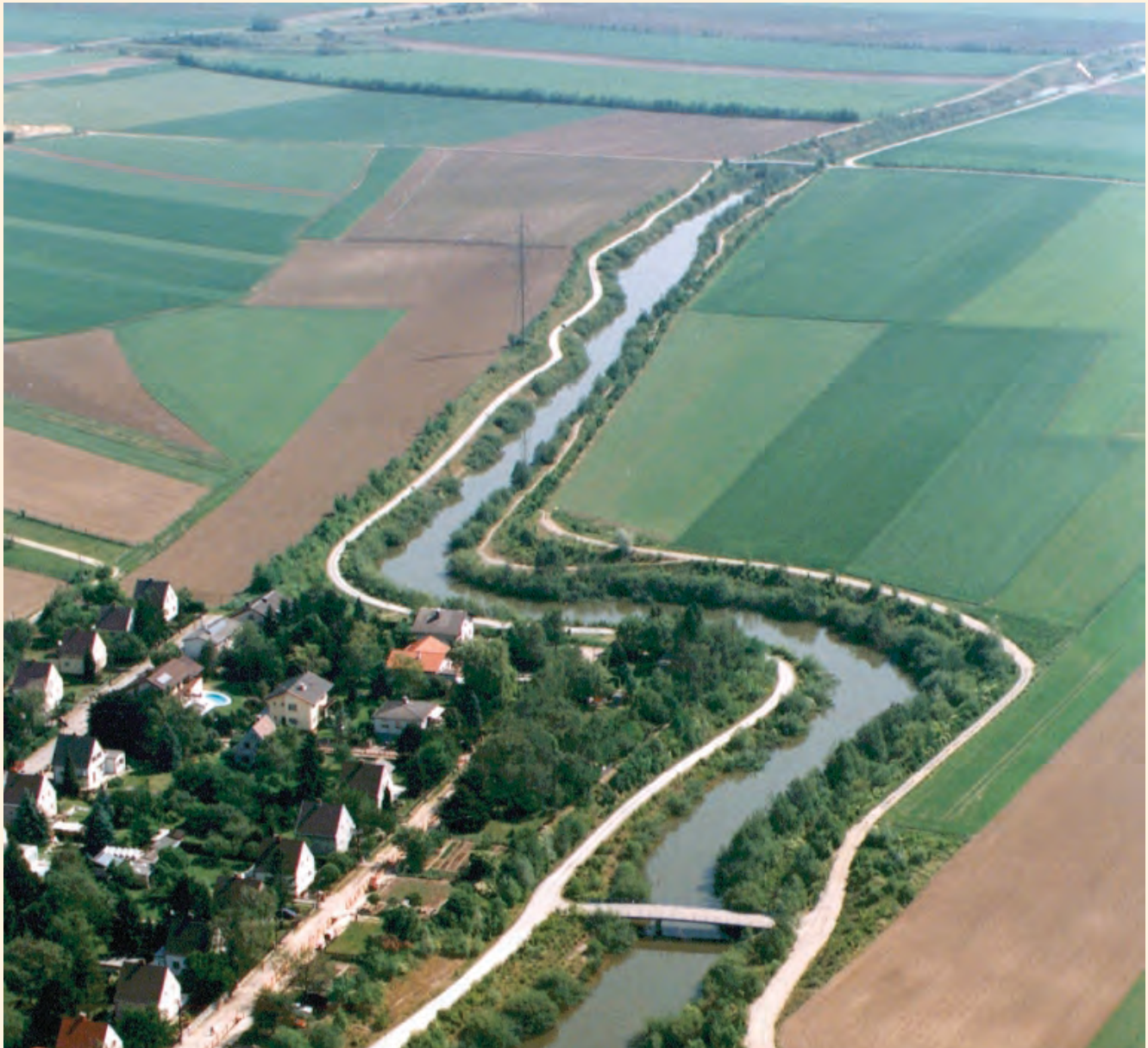
Marchfeldkanal - Tilakstraße, 1210 Wien
