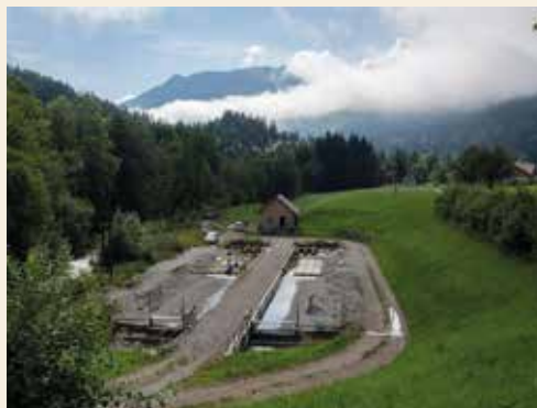
Die HyTEC Anlage am Standort Lunz
