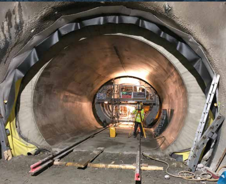
Herstellung der Innenschale im Querschlag
