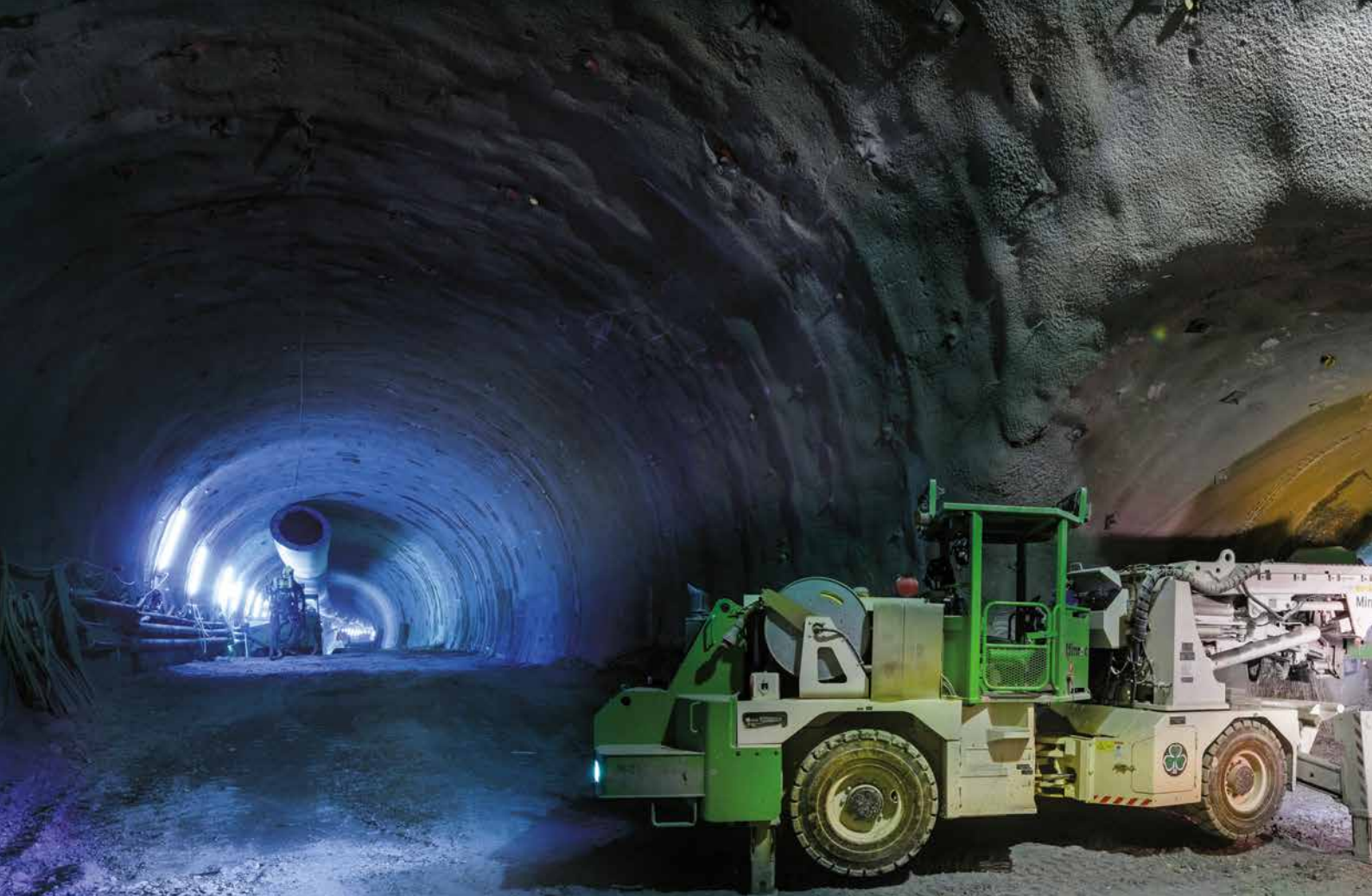
Gitterarbeiten im Querschlag
