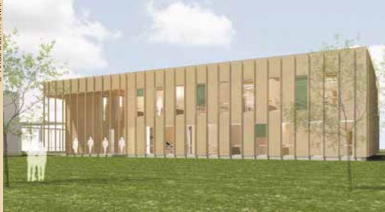
schen Gebäudehülle aus unbehandeltem Lärchenholz Niedrigenergiehausstandard. Eine mechanische Be- und Entlüftung sorgt für durchwegs gute Luft in den Räumen. Darüber hinaus kommen eine Nachtkühlung und ein außenliegender Sonnenschutz zum Einsatz.
